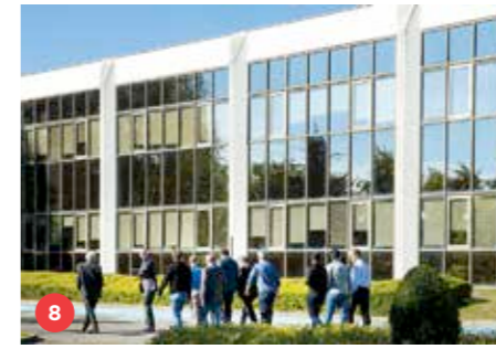
8 L'entreprise HP, Les Ulis, Courtabœuf
