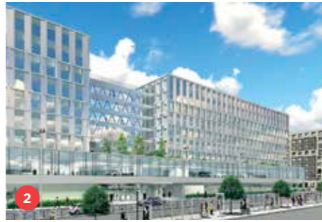
2 Le Carré, immeuble International à Montigny-le-Bretonneux, SQY Centre université
