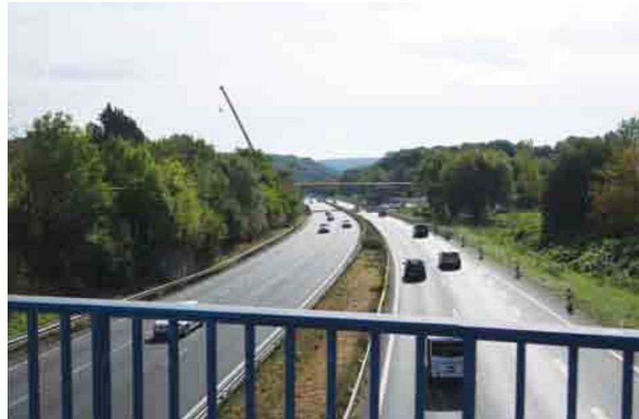
Nouveau pont sur la RN118 pour le passage de l'Express 91-06 © STIF
