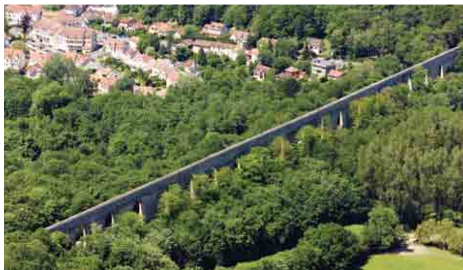
L'Aqueduc de Buc mis en service en 1686 conduit l'eau par gravité jusqu'aux bassins et fontaines du château de Versailles © Philippe Guignard
